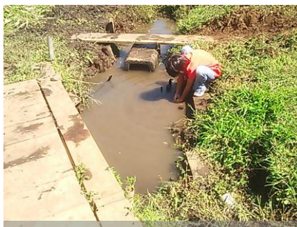
改修した洗い場
