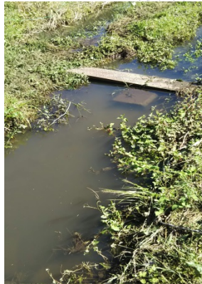
大雨であふれた排水路
